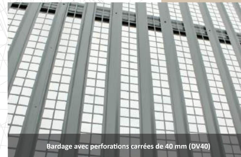
Bardage avec perforations carrées de 40 mm (DV40)
