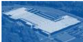
Hörmann KG Eckelhausen, Allemagne
